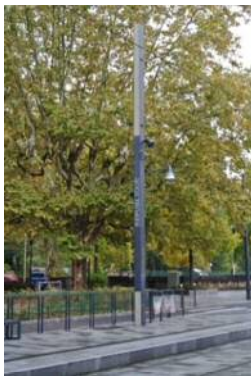
架線柱はH鋼を活用し、コスト低減 (ブザンソン)
