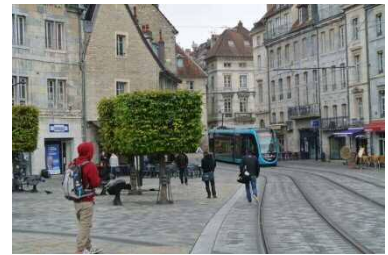
沿道の住宅の壁面に支線を添架し、景観に配慮(ブザンソン)
