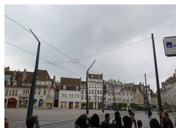
架線レス化・デザインされた架線柱で景観性を向上
