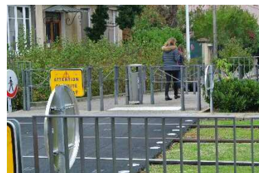
トラムの横断部、ポールをZ型に配置 することで、人はトラムが来る方向に 視線を向けるよう工夫(リヨン)
