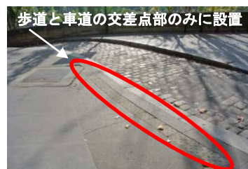
歩道と車道の交差点部のみに設置 視覚障がい者誘導ブロック(パリ)
